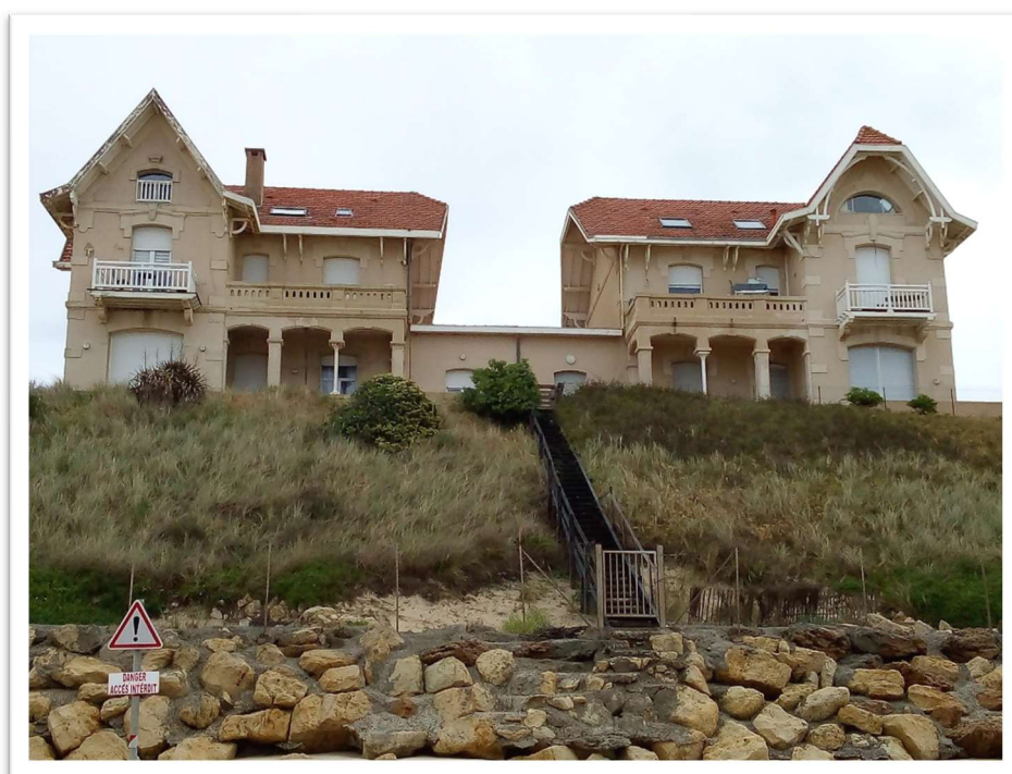
Photo 1 : Villas jumelles (17 mai 2019, ©CCGL)
