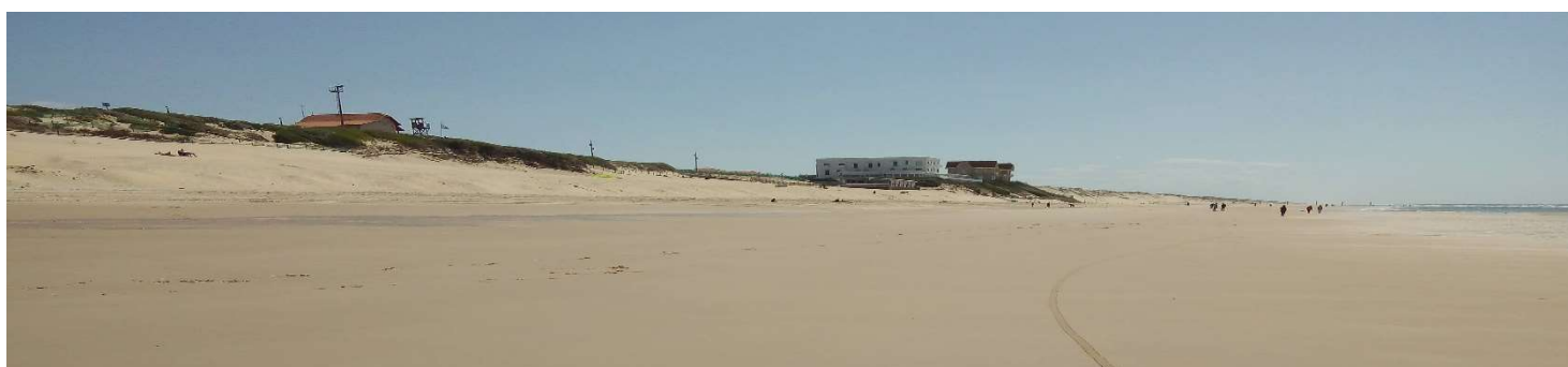
Photo 2 : au fond, les bâtiments de première ligne menacés à court terme (16 avril 2021, ©CCGL)
