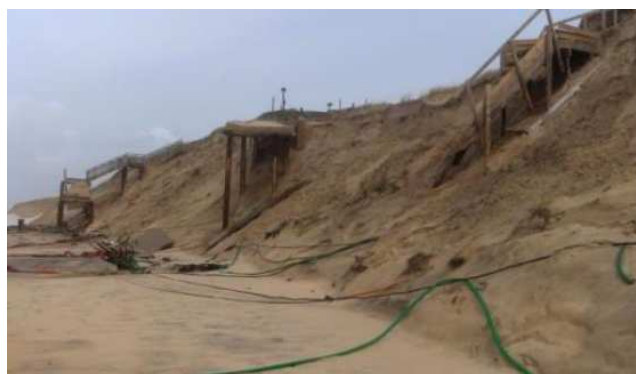
Dégâts de la tempête 2013-2014
