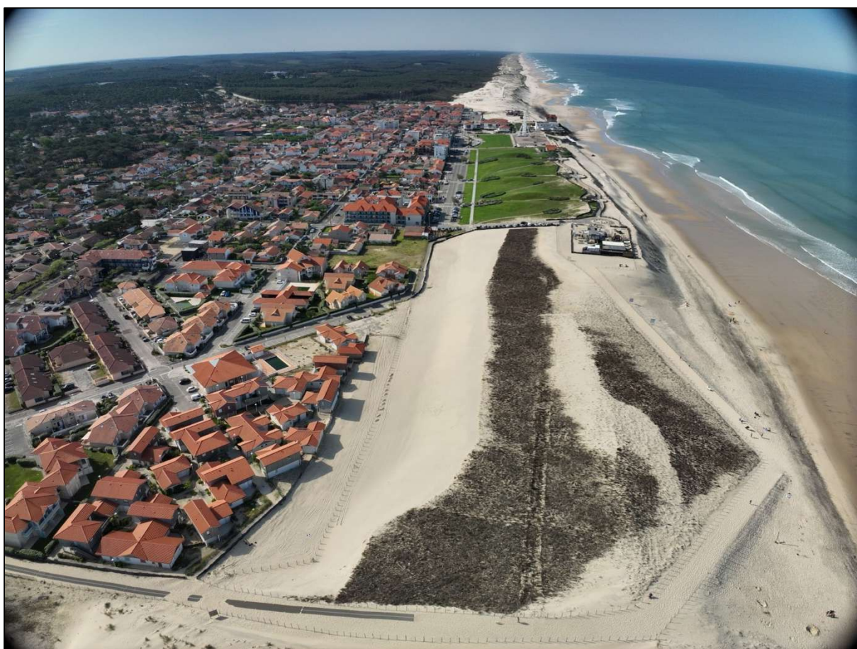
Figure 22 Photographies aériennes par drone du reprofilage de la dune nord, respectivement le 04 mars 2025 pendant le reprofilage et le 30 avril après reprofilage ©CCGL/Drone On Air, ©ONF.
