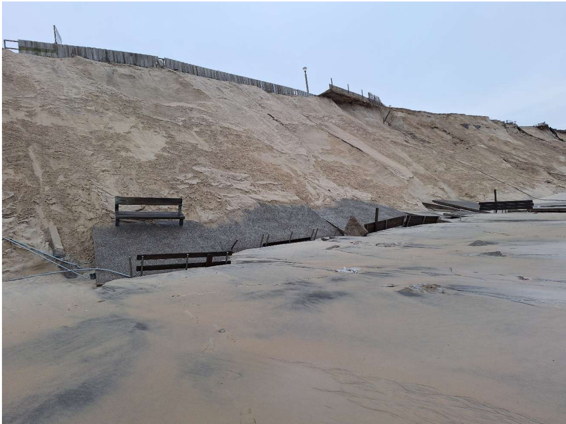
Photo 4 – Plage Nord : effondrement de la promenade dû au recul brutal de la dune qui présente une falaise d'érosion avoisinant 12 voire 15 mètres de hauteur (02/02/2026), ©CdC des Grands Lacs.
