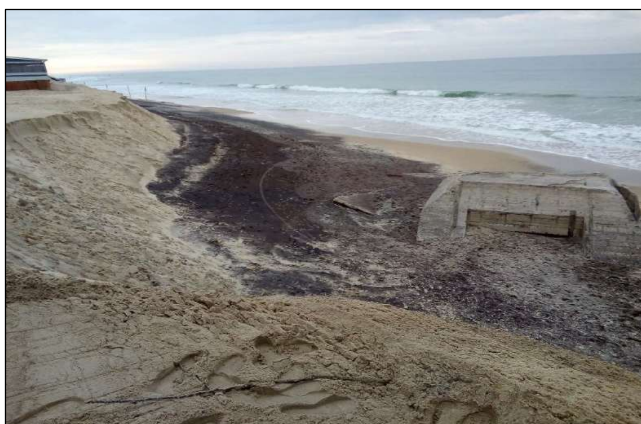
Figure 9 Photo du blockhaus plage Centrale (6 janvier 2021) une semaine après la tempête « Bella ». Entre le pied de dune sur le linéaire moyen et le blockhaus, c'est une différence de + 10 m qui a été mesurée ©CCGL
