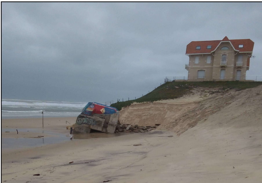
Figure 19 février 2024, encoche d'érosion marquée à l'arrière du Blockhaus Sud, niveau de plage relativement bas ©Commune de Biscarrosse
