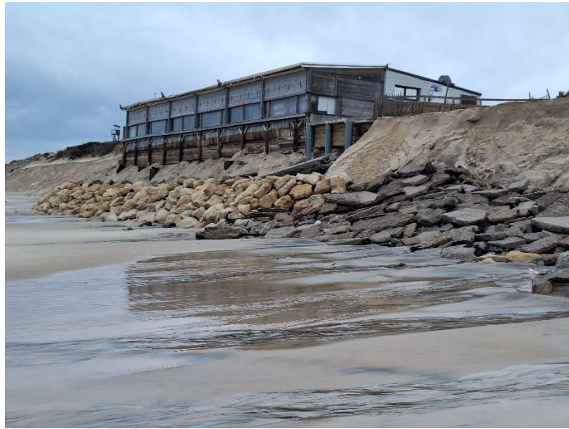
Photos 2 & 3 – Plage centrale, l'accès en béton est détruit et le restaurant La Playa se retrouve sur le Domaine Public Maritime (DPM) tant le recul est impressionnant, au point que l'ensemble restant constituera un cap définitivement vulnérable et source de fragilisation des zones situées de part et d'autre, 02/02/2026 ©CdC des Grands Lacs.
